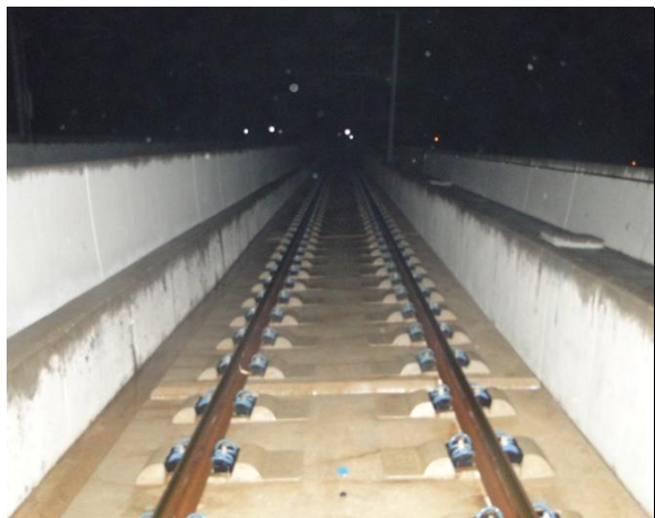
교량 상부 전경
