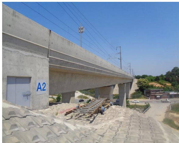
교량 측면 전경
